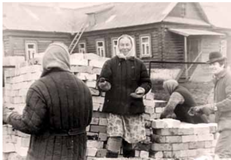
Иске хастаханәнең балалар тудыру корпусы янында яңа хастаханә төзи башлау өчен әзерлек эшләре бара. Анда эшләүчеләрнең берсе дезинфектор Рәйсә Котдусова безгә карап тора.
